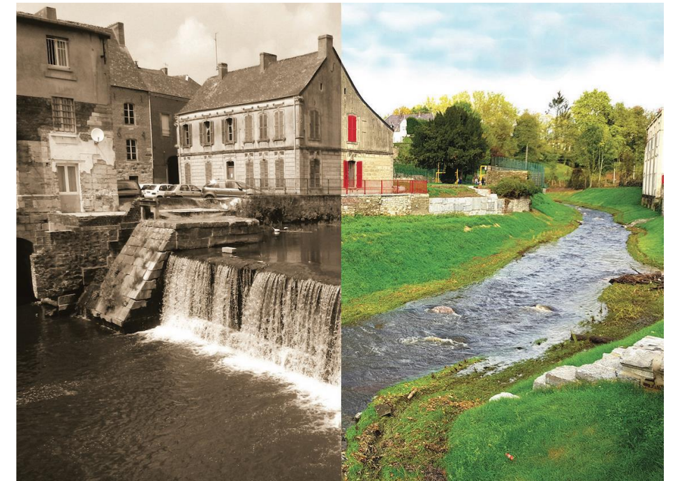
Avant/après le dérasement du seuil Pasteur (commune d'Hirson) (©EPTB entente Oise-Aisne et Agence de l'Eau Seine Normandie)
