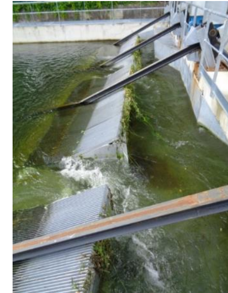
Prise d'eau ichtyocompatible (dévalaison)
